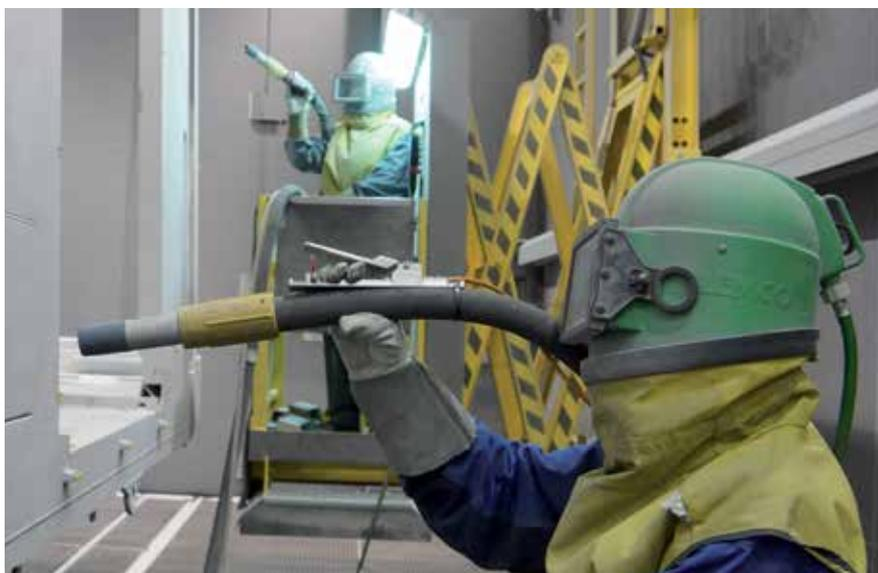
*Дробеструйная камера для рельсовых транспортных средств, оснащенная телескопической подъёмной рабочей площадкой*
