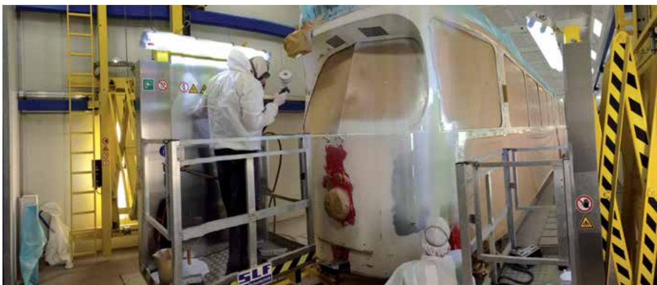
Телескопические подъёмные рабочие площадки в окрасочной и сушильной камере для трамваев
