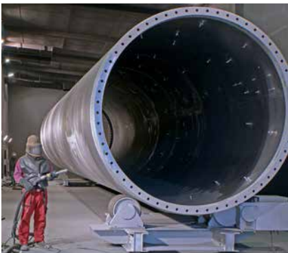
Freistrahlnraum mit Werkstückdrehvorrichtung für Windkraftturmsegmente
