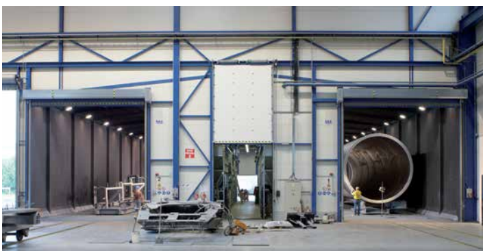
Zwei identische Freistrahlräume mit mittig angeordnetem Maschinenraum
