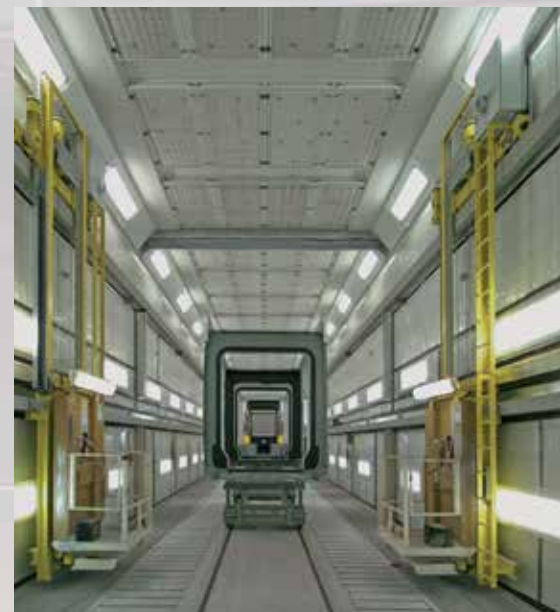
Комбинированная окрасочно-сушильная камера для пассажирских вагонов с секционной вентиляцией.
