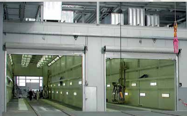
Комбинированная окрасочно-сушильная камера для лопастей ветряков с секционной приточно-вытяжной вентиляцией с вертикальной подачей воздуха.
