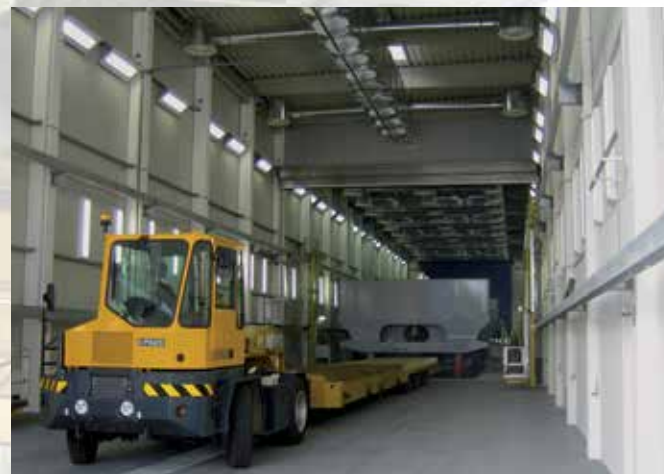
Кабина очистки под высоким давлением и комбинированная окрасочно-сушильная камера с секционной системой вентиляции для крупногабаритных изделий.
