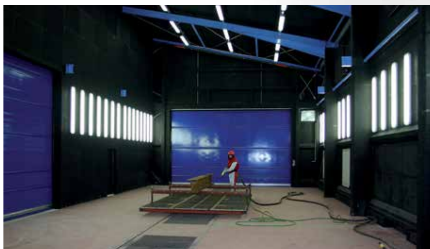
Дробеструйная камера для деталей кораблей на предприятии «Meyer Werft», вкл. пневматическую систему обратной подачи дробы из части камеры.
