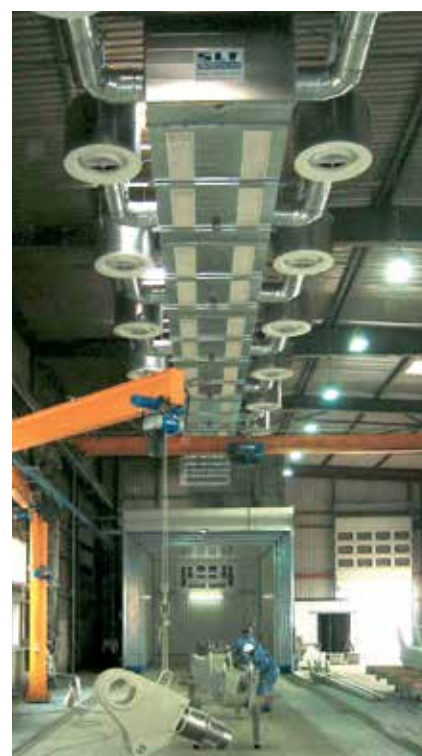
Техника направленного воздушного потока с помощью сопел с телескопической сушилкой.
