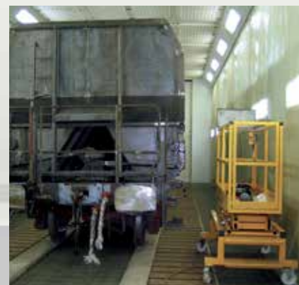
Комбинированная окрасочно-сушильная камера для грузовых вагонов.
