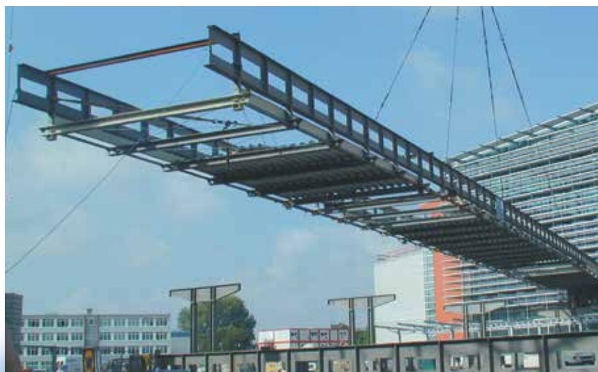
Пассажирский мост для аэропорта в Дрездене, подвергающий обработке в антикоррозионном центре SLF в г. Mühlau.
