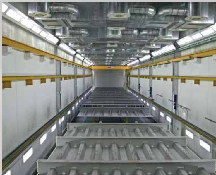
Комбинированная окрасочно-сушильная камера для элементов моста с секционной вентиляцией с помощью сопел направленного действия.
