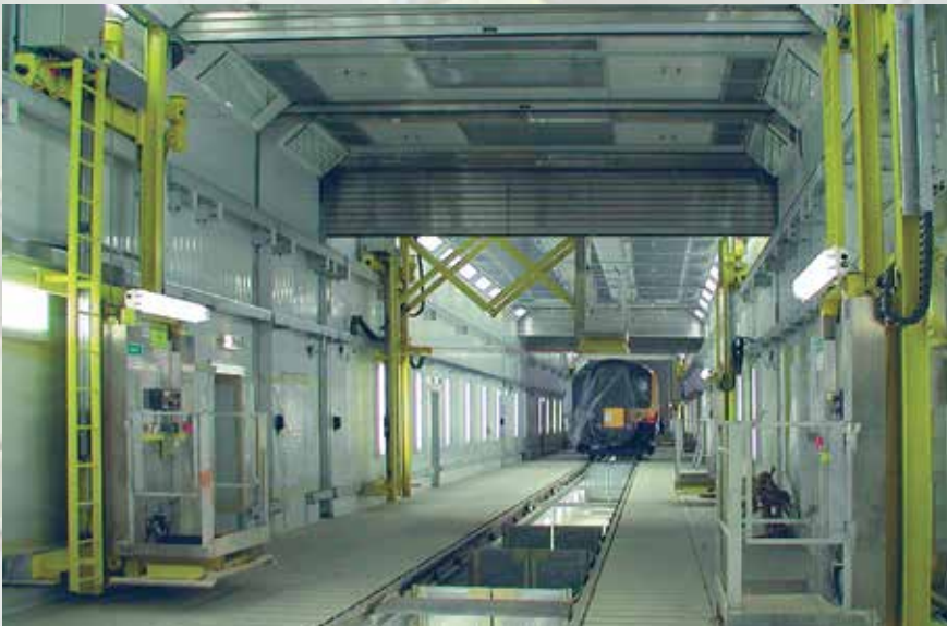
Настенные подъемные площадки в окрасочной камере для пассажирских вагонов в компании Siemens AG Transportation Systems в г. Krefeld.
