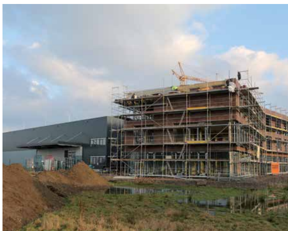
Der im Bau befindliche neue SLF -Hauptsitz, Fertigstellung im Spätsommer 2016
