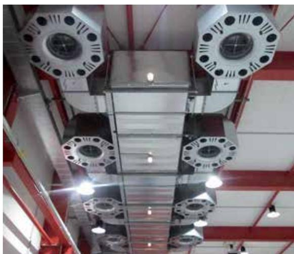
Разработанная компанией SLF и запатентованная система сопел направленного действия может целенаправленно подать подогретый технологический воздух с больших высот в направлении маляра и достигает там предписанные скорости вертикального воздушного потока. Данная система является особенно эффективной в сочетании с секционным принципом подвода воздуха, который реализуется с помощью нашей системы определения местонахождения маляра.
