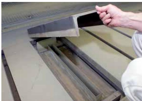
Выдерживающие большую нагрузку отбойные сепараторы представляют собой первую ступень двухступенчатой системы отделения лакокрасочного материала. Благодаря их особенной конструкции можно без проблем перемещаться по отбойным сепараторам с транспортными средствами.
