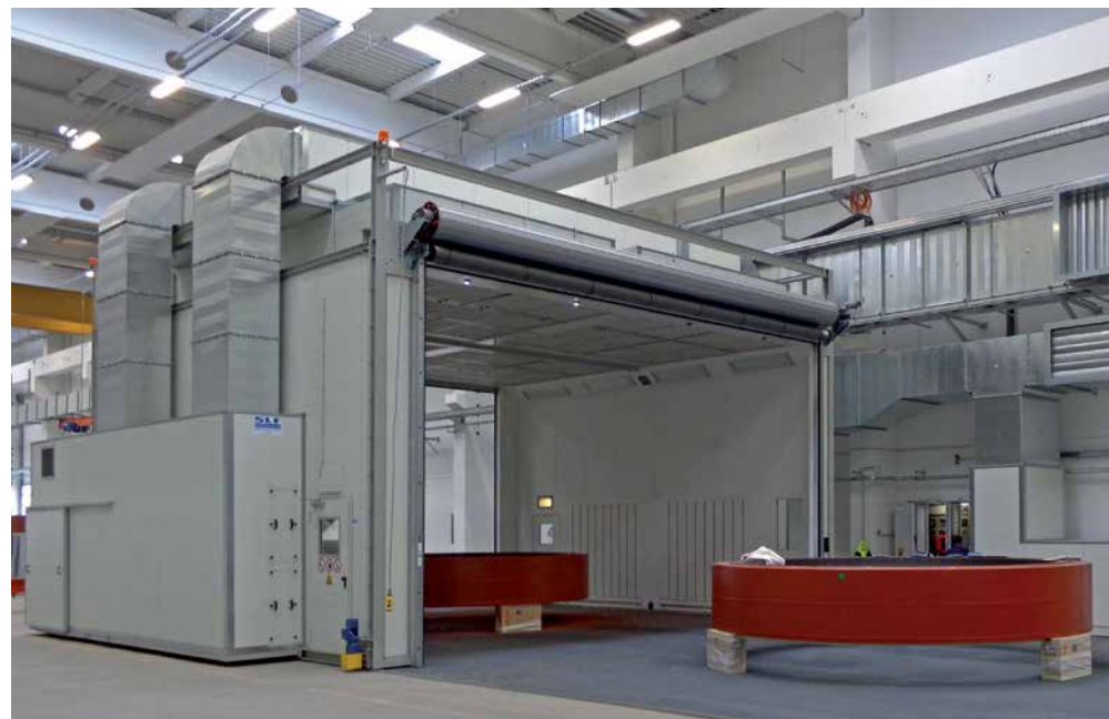
Nach der Beschichtung verbleiben die Werkstücke an ihrem Platz und die Kabine verfährt in eine neue Bearbeitungsposition.
