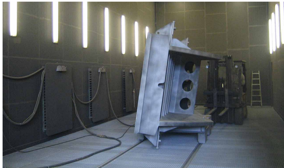
Дробеструйное помещение с устройством возврата дроби.
