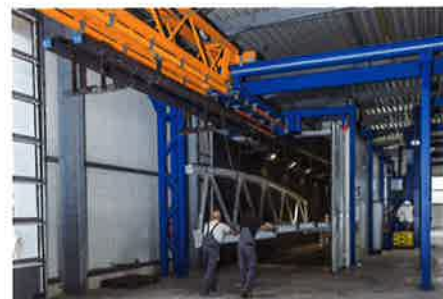
Fördersystem zu den einzelnen Bearbeitungsstationen © SLF Oberflächentechnik GmbH
