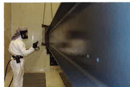
Beschichtung mit Nasslack © SLF Oberflächentechnik GmbH
