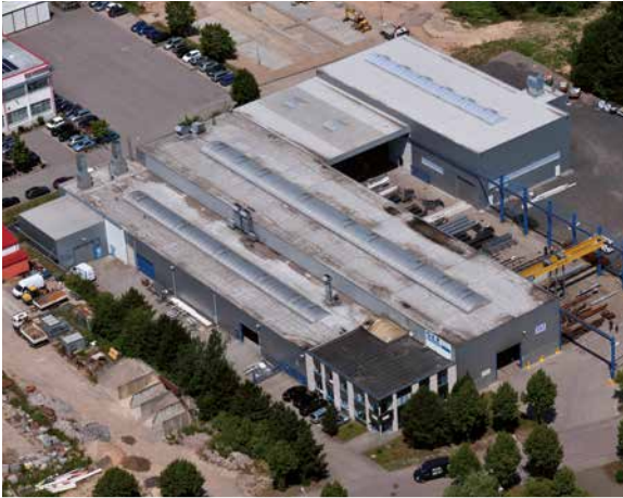
Der Korrosionsschutzbetrieb im SLF -Werk Mühlau
