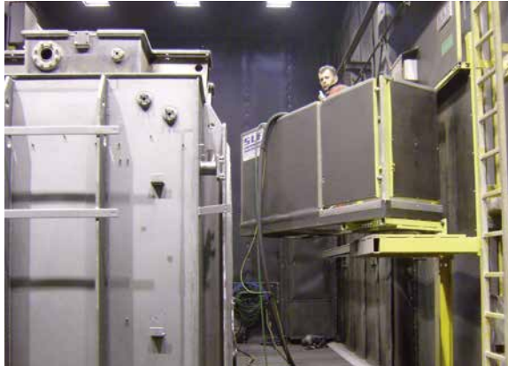
Schwenk-Hubarbeitsbühne in einem Strahlraum
