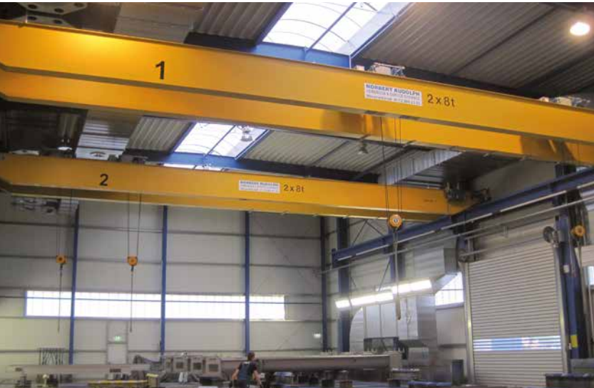
In unserem Werk in Mühlau stehen großzügige Lager- und Produktionsflächen zur Verfügung.
