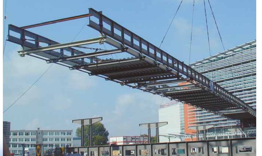
Mühlau'daki SLF-Koroyondan-Koruma-Merkezi'nde işlenmiş, Dresden Havaalanına ait yapısalçelikten bir yolcu köprüsü.
