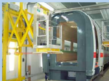
Окрасочный цех с перемещающимися вдоль стены разводными рабочими площадками
