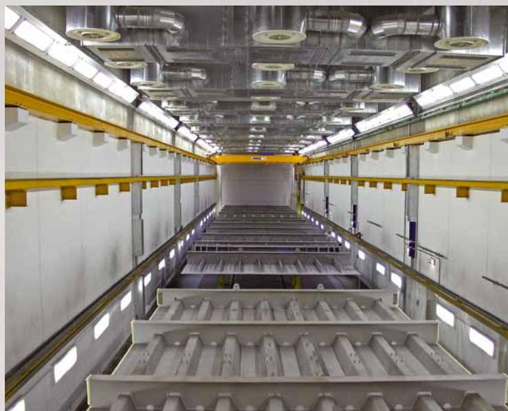
Комбинированная окрасочно-сушильная камера для элементов моста с секционной вентиляцией за счет вертикально направленного воздуха.
