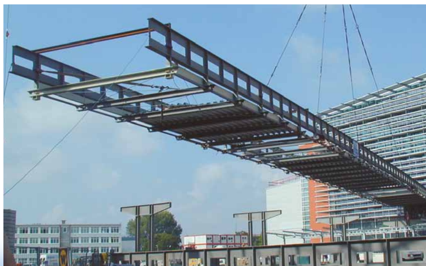
Пассажирский мост для аэропорта в Дрездене, произведенный анти-коррозионным центром в городе Mühlau.
