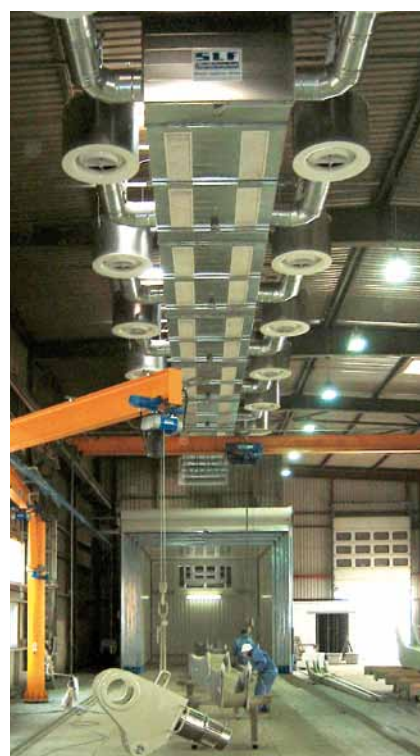
Приточно-вытяжная вентиляция направленного действия с телескопической сушильной камерой.
