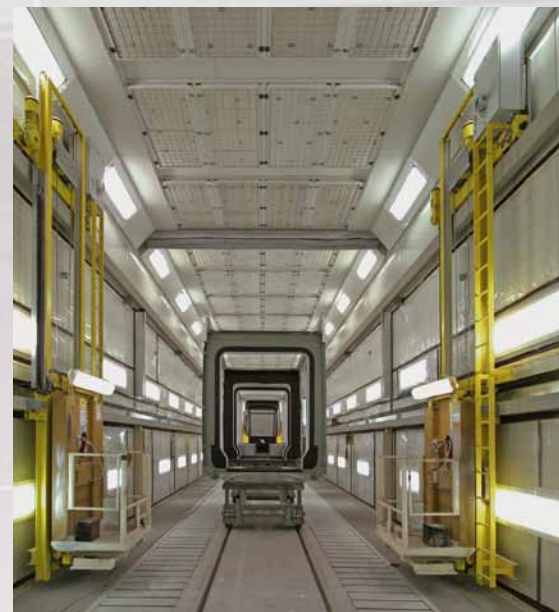
Kombinowana kabina natryskowa i suszarnicza do wagonów pociągów z sekcijną wentylacją.
