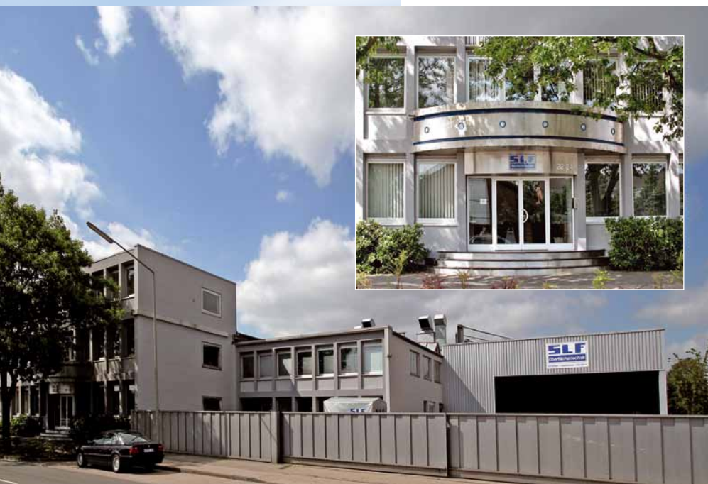
Vista da sede da SLF em Greven-Reckenfeld.
