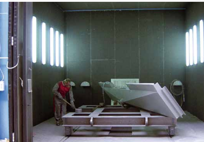
Installation de sablage pour des grosses pièces.
