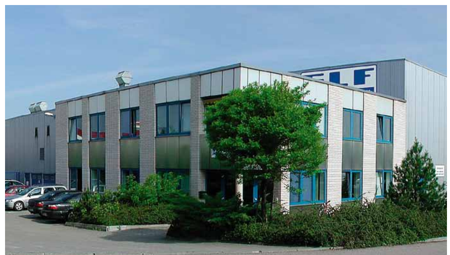
Usine à Mühlau près de Chemnitz (Construction d'installations et centre anti-corrosion).
