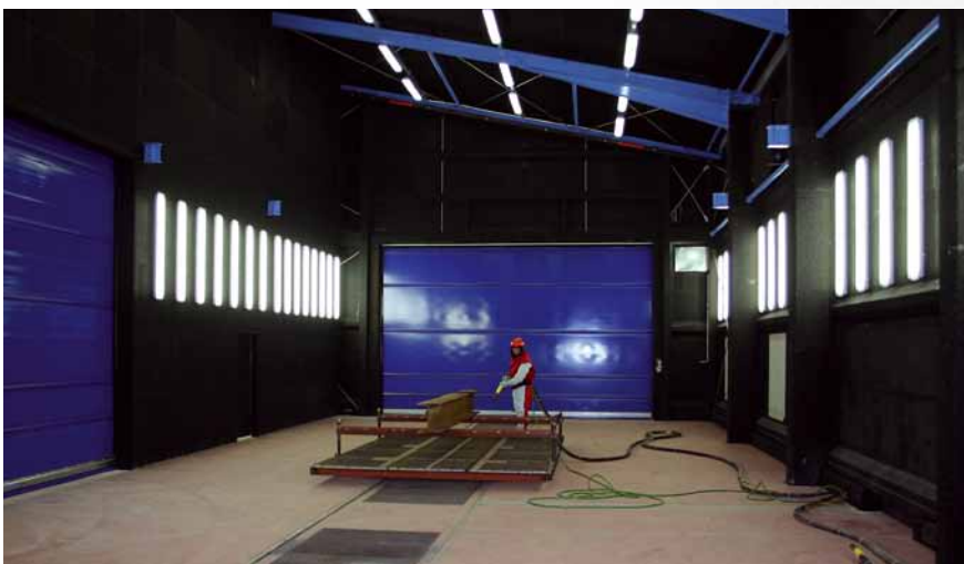
Salle de sablage pour des composants navals du Meyer Werft, avec système de récupération pneumatique partielle de l'abrasif.
