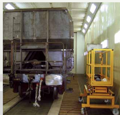
Cabinas combinadas de pintura y secado para vagones de tren.
