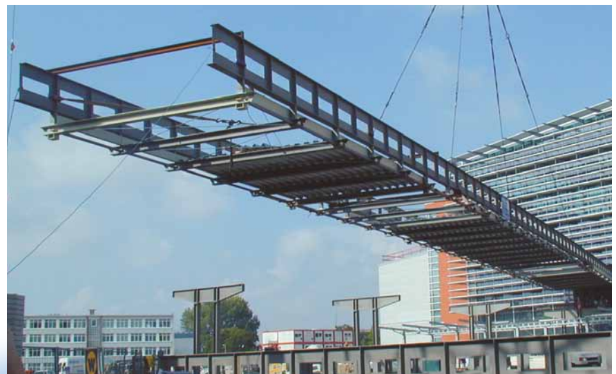
Passagierbrücke für den Flughafen Dresden, bearbeitet im SLF-Korrosionsschutzzentrum in Mühlau.
