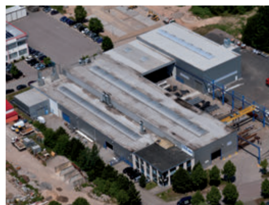
Der Korrosionsschutzbetrieb im SLF-Werk Mühlau heute
