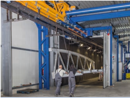
Bis zu 16,20 Meter lange Teile können über das Fördersystem zu den einzelnen Bearbeitungsstationen transportiert werden
