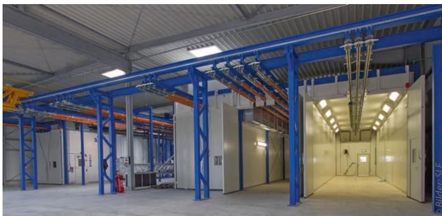
Ansicht der Gesamtanlage. Von links nach rechts: Freistrahtraum, kombinierte Spritz- und Trockenkabine, Lacktrockner und Hochdruckreinigungskabine.
