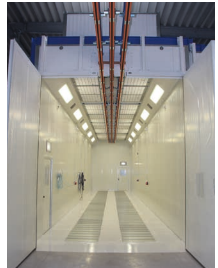
Blick in die kombinierte Spritz- und Trockenkabine mit sektionaler Be- und Entlüftung und Unterflurabsaugung über Prallabscheidersegmente
