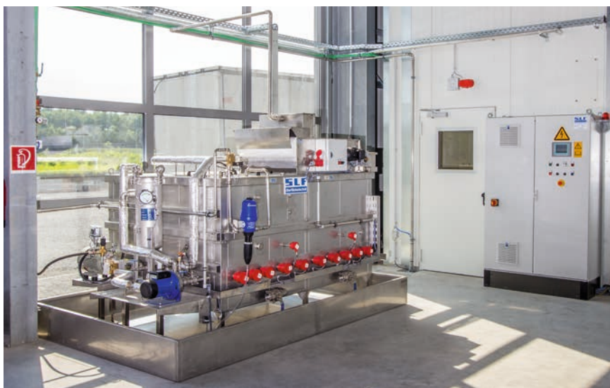
Die Prozesswasseraufbereitung und der Schaltschrank für die Hochdruckreinigungskabine befinden sich gut zugänglich im hinteren Teil der Anlage
