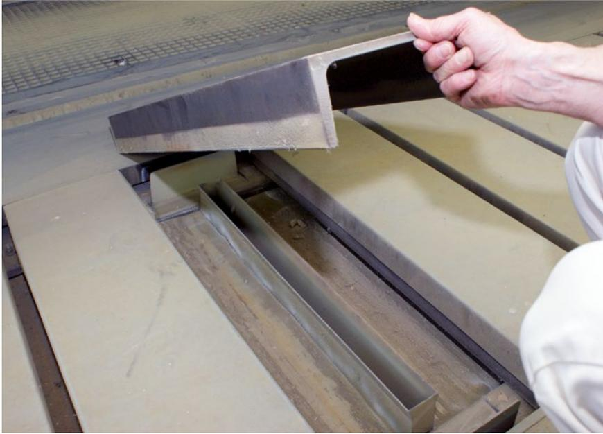
Die Absaugung des Lack-Oversprays erfolgt über in den Boden eingelassene Kanäle mit Prallabscheidern.
