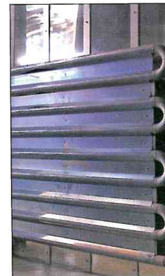
Die Dunkelstrahler besitzen eine Fläche von etwa 4 m 2 und erzeugen die Wärme durch Verbrennung eines Sauerstoff-Gas-Gemisches.
