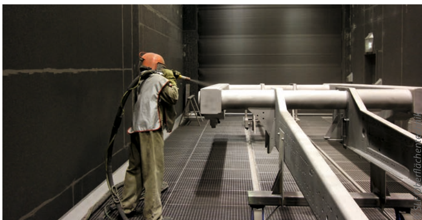
Im manuellen Strahlprozess werden einzelne Bauteile bei Paul Nutzfahrzeuge im neuen Strahlraum mit vollflächigem Strahlmittelrücktransport und Deckenkran gestrahlt
