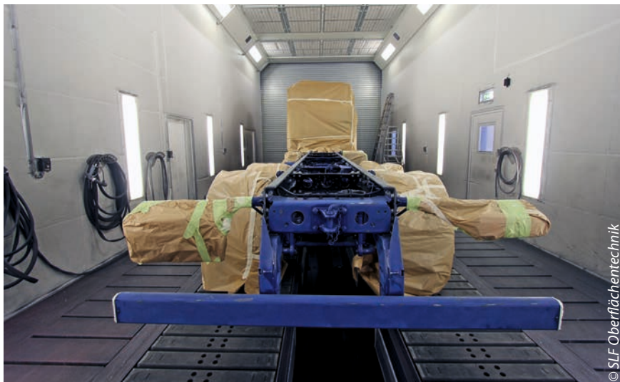
Die Lackierkabine mit sektionaler Belüftung und Wärmerückgewinnung setzt Maßstäbe beim Thema Energieeinsparungen
