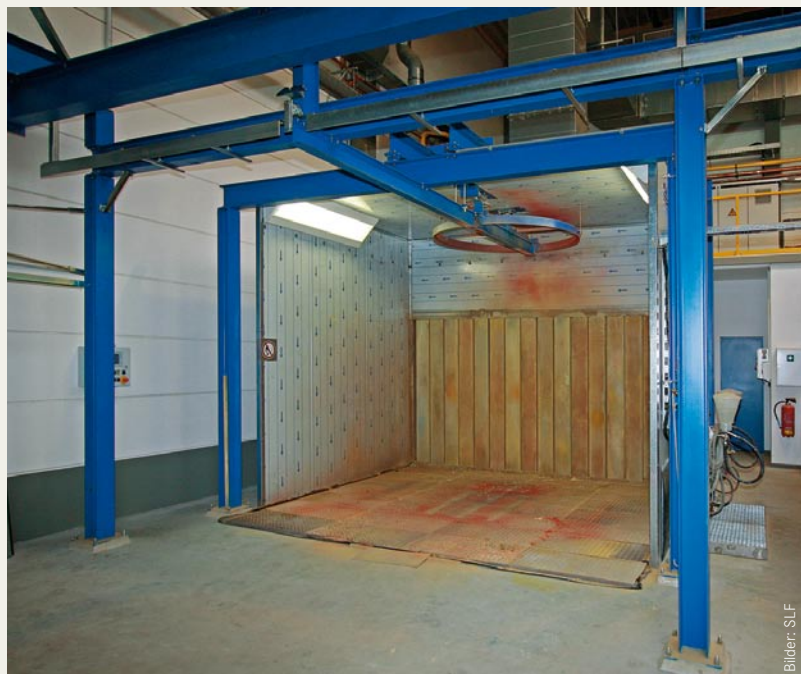
Die Kleinteillackieranlage besteht aus einem Spritzstand, einer Abdunstzone und einem Trockner
