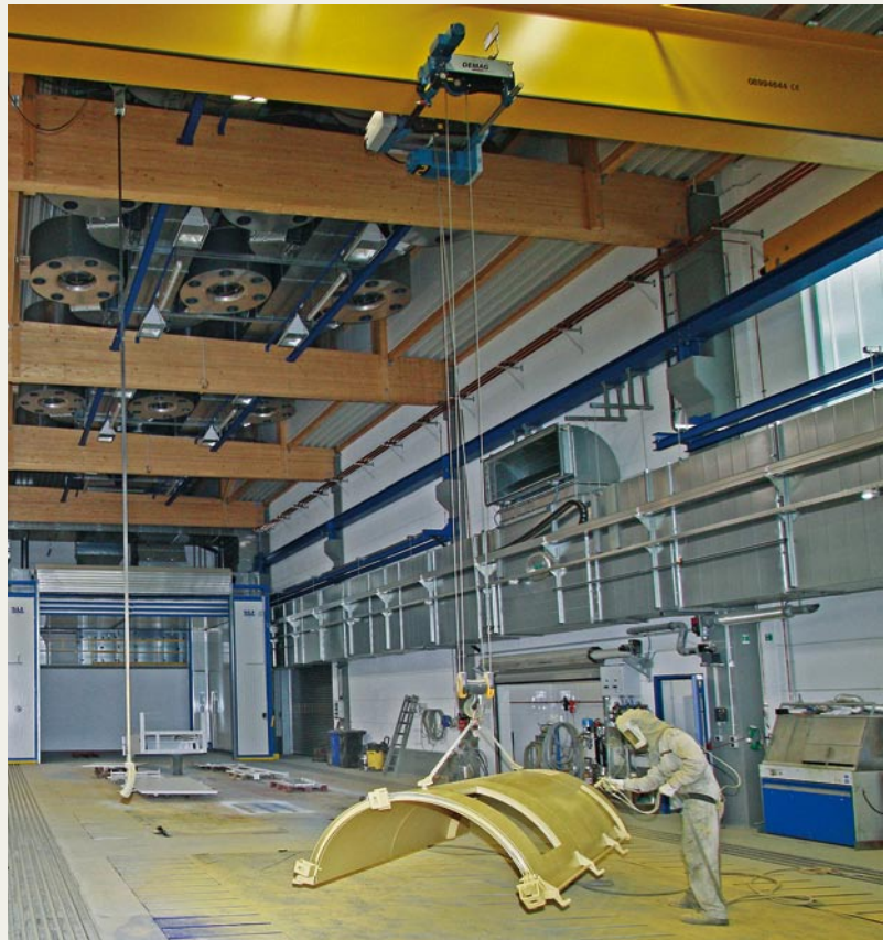
Der Freiflächenlackierplatz verfügt über eine energiesparende sektionale Lüftung
