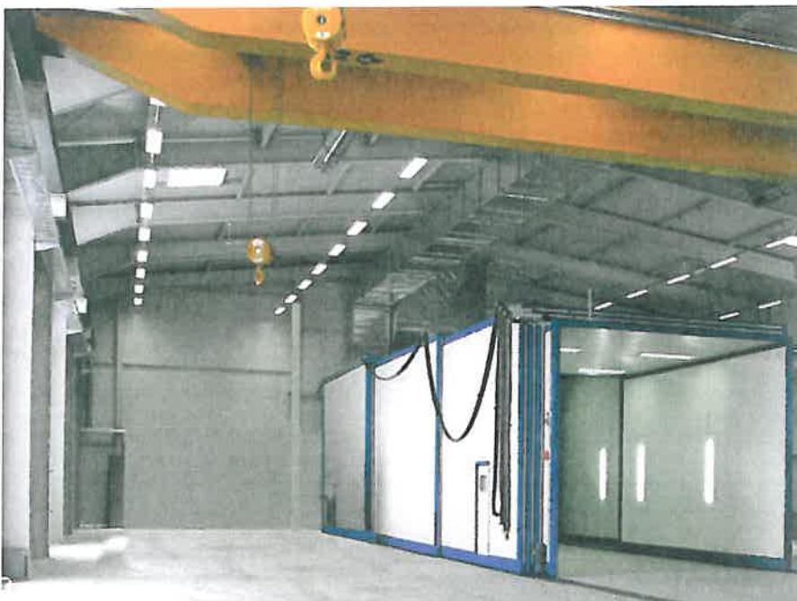
Mit einem Teleskoprockner lassen sich flexible Raumnutzung und Energieeffizienz kombinieren.
