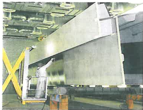
Lackierung eines Teilsegmentes der 584 m langen Strelasundbrücke von Stralsund nach Rügen auf einer Freiflächenlackieranlage.
