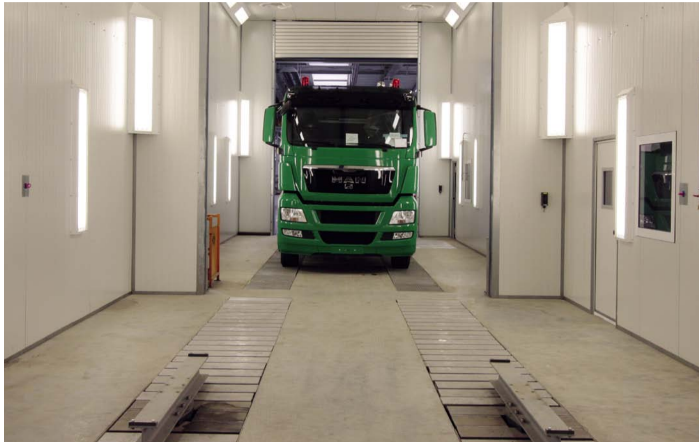
Das neue Oberflächenzentrum umfasst drei 70 m lange Lackierlinien, jeweils bestehend aus einer Vorbereitungskabine, einer Grundier- sowie einer Lackierkabine und einem Trockner. Zwei der Lackierlinien sind mit einem Bodenfördersystem ausgestattet.
