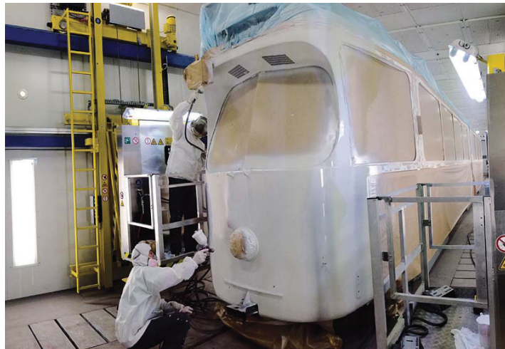
Die Wiener Linien lackieren ihre Schienenfahrzeuge künftig in einer neuen Waggon-Lackierkabine, die mit sektionaler Belüftung und einer automatischen Personenerkennung ausgestattet ist. Quelle: SLF
