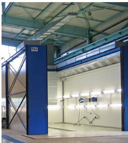
Hochdruckreinigungskabine mit offenem Dach und horizontaler Luftschleieranlage
